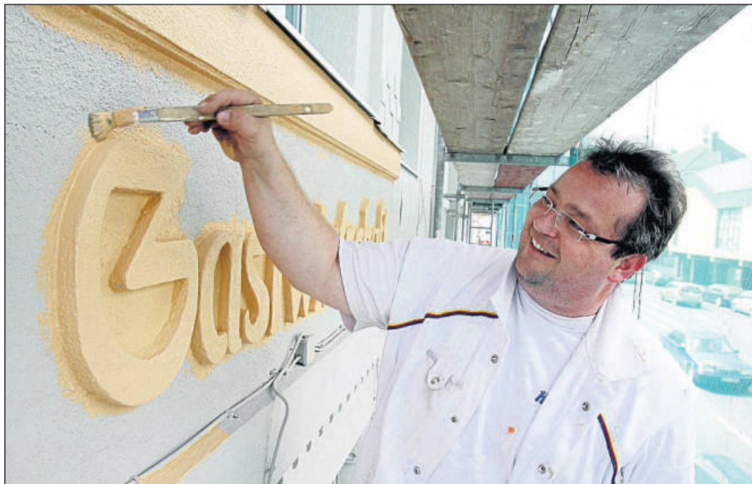
Neuer, alter Glanz: Malermeister Stephan Schwiegershausen orientiert sich bei der Gestaltung des Gasthauses am ursprünglichen Farbton der Fassade.
